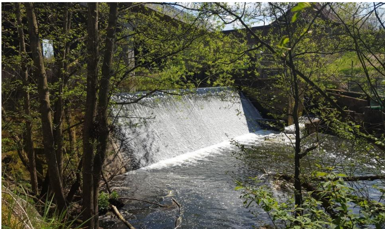
Bild: Exempel på partiellt vandringshinder i form av en betongfördämning med kammartrappa (till höger i bild) i Rååns huvudfåra.
