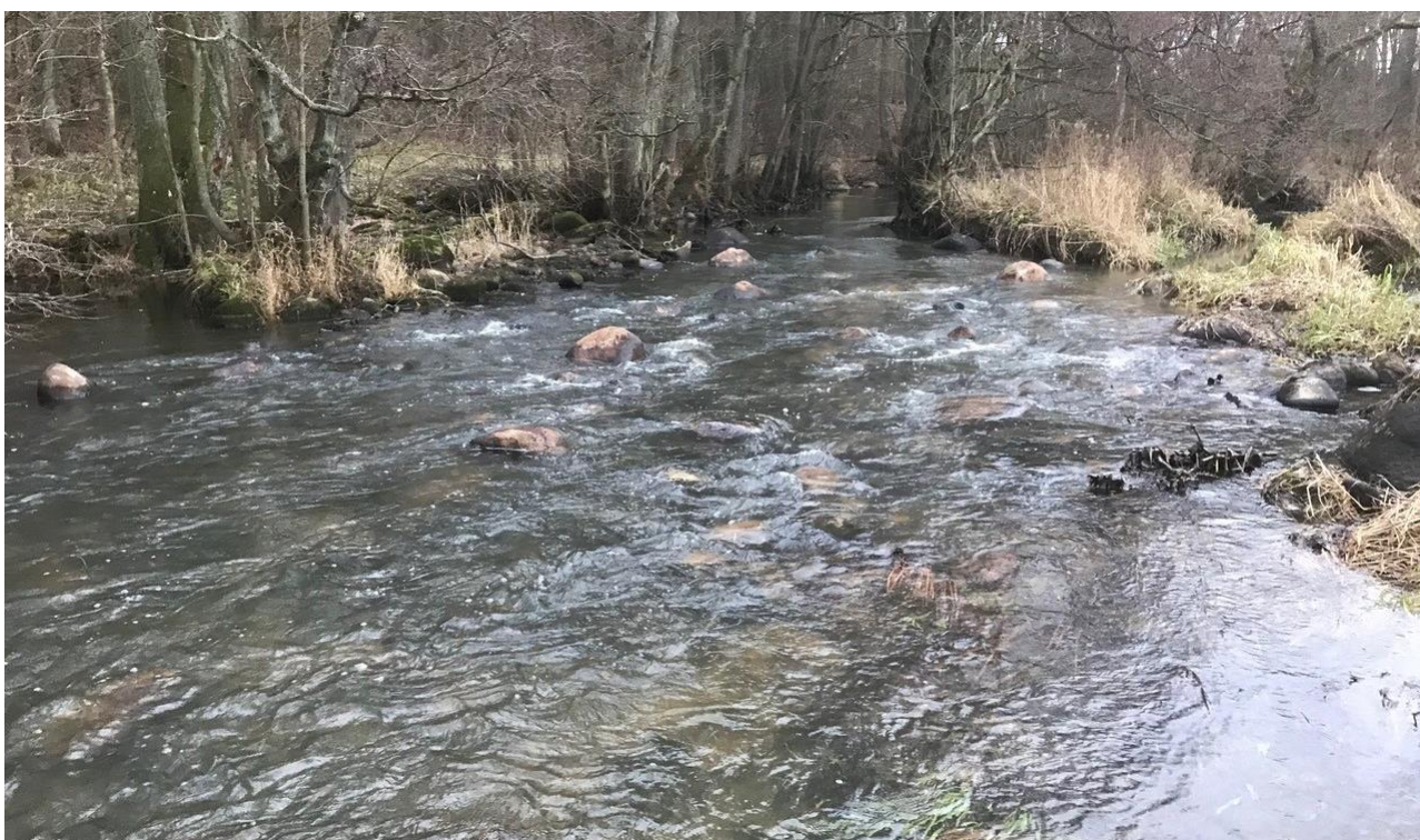
Bild: Exempel på blockrestaurerad stömsträcka vid Gantofta i Råån. Block och sten har tagits från rensvallar längsmed strandkanten och lagts tillbaka i fåran.
